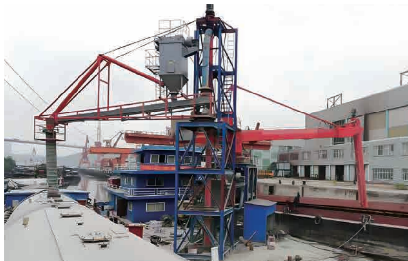
■ 300吨/小时卸船装车系统 300 tons/hour Unloading and Loading System
